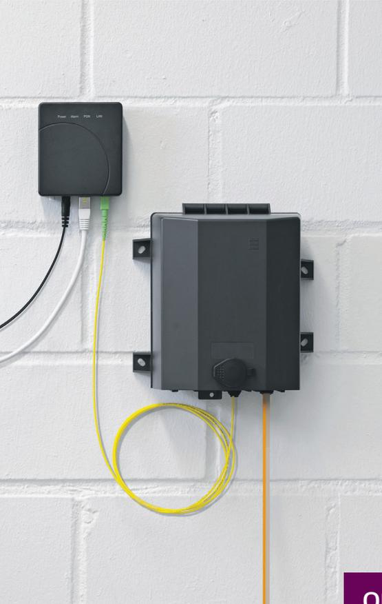
energis installiert das Glasfaser-Netzabschlussgerät (ONT = Optical Network Termination). Dieser wandelt die eingehenden Lichtsignale in das jeweils benötigte Datensignal um, also passend für:
