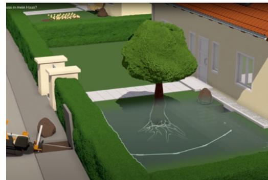
Der Bohrkopf eines Spülbohrers ist steuerbar und kann Hindernisse umgehen.
